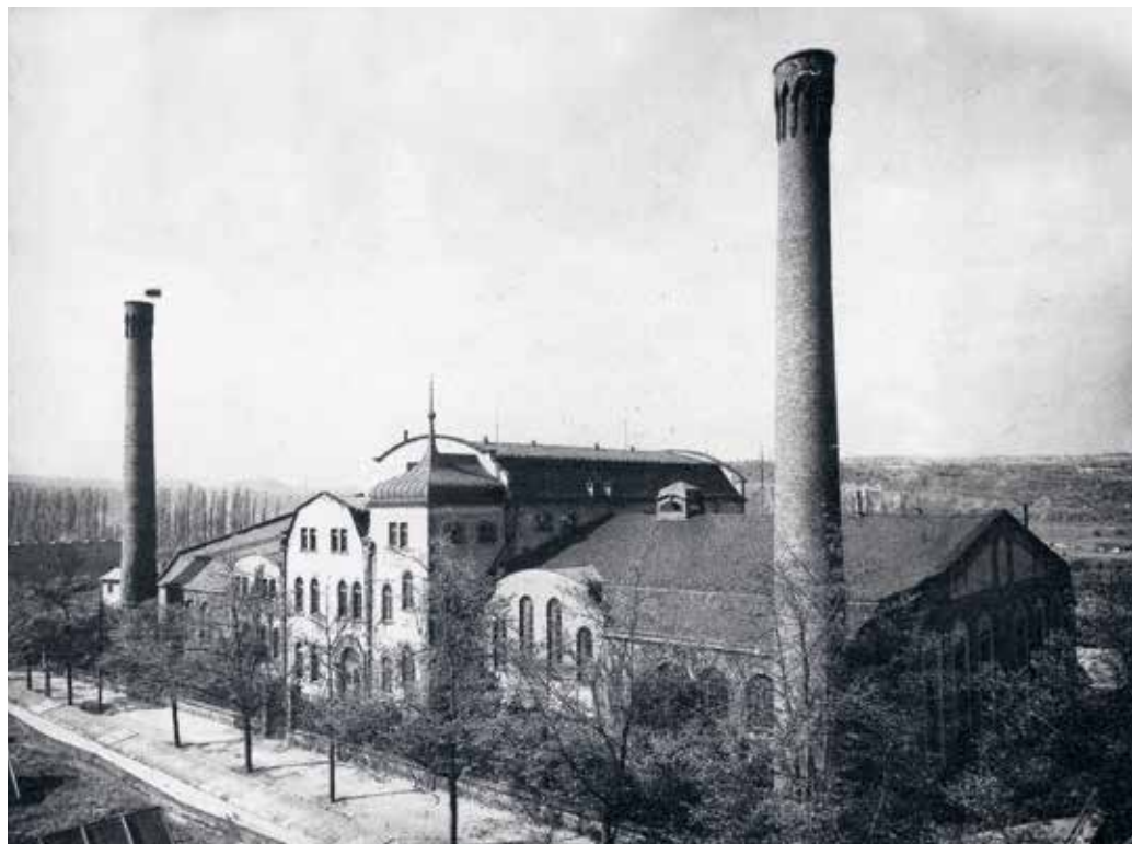
▲ Lindleyova čistící stanice s úspěchem fungovala po několik desetiletí až do roku 1965.
