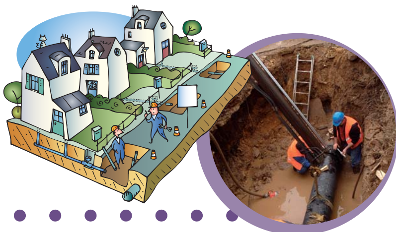
Oprava prasklého vodovodu v Českolipské ulici
